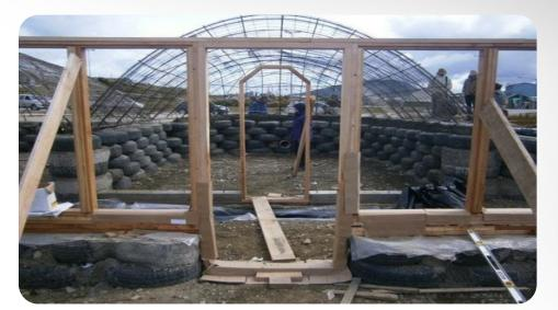
municipales para presenciar el hecho. En una media hora estábamos aplaudiéndonos por haberlo puesto en su lugar. La cúpula es una estructura de hierros del 16 y del 12, en forma de medio cilindro con una punta terminada en semiesfera, tiene malla cima del 6 por arriba que le da cuerpo y por debajo metal desplegado para permitir el revogue, es pesada pero se tiene que bancar el peso de toda la tierra que llevará arriba.
